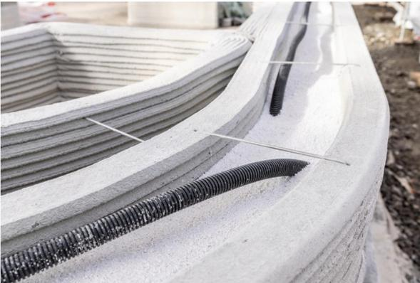
**Dämmung und Leerrohre in den Druckprozess integriert**
